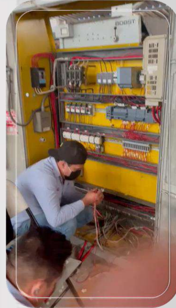
Instalación de Panel de control
