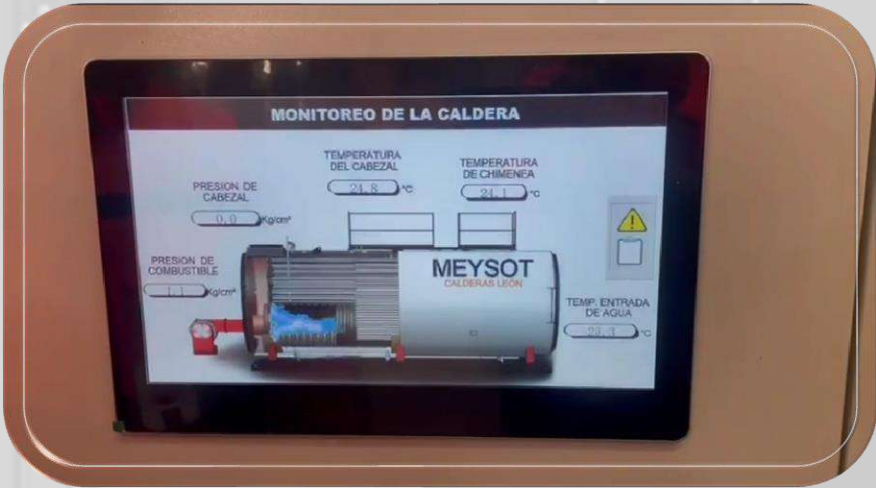
Sistema de Monitoreo de Calderas
